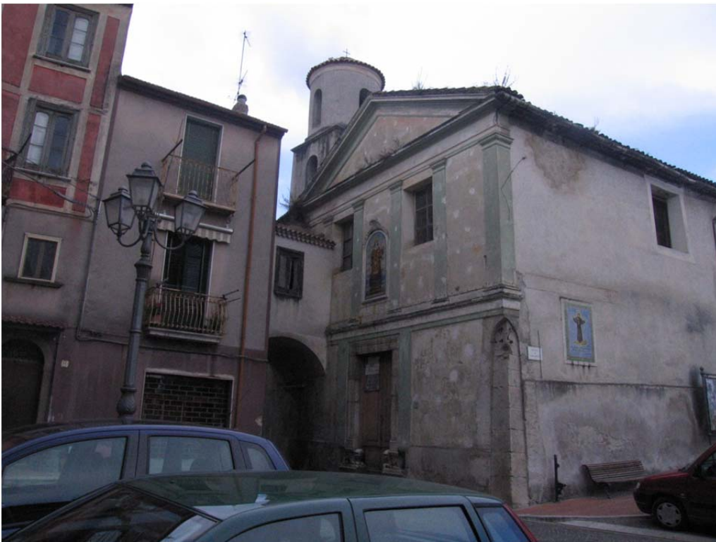
Facciata principale : si notano le perforazioni effettuate nel I Lotto dei Lavori (1989-1992)
