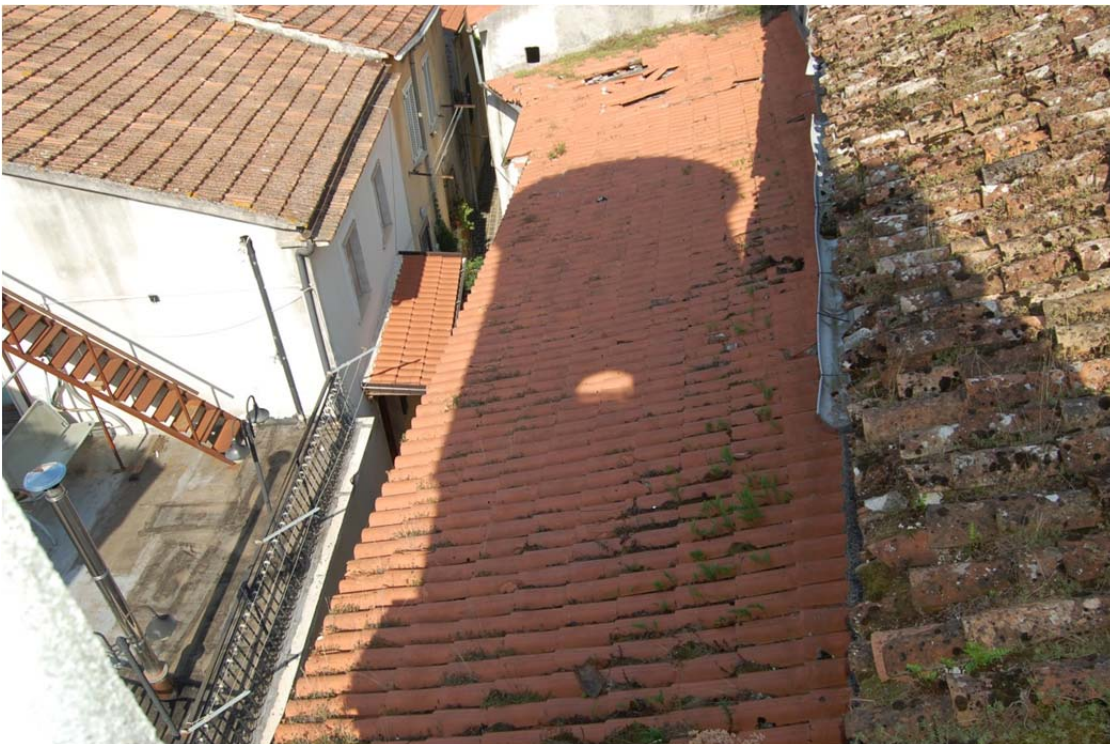
La copertura della navata laterale nello stato attuale
