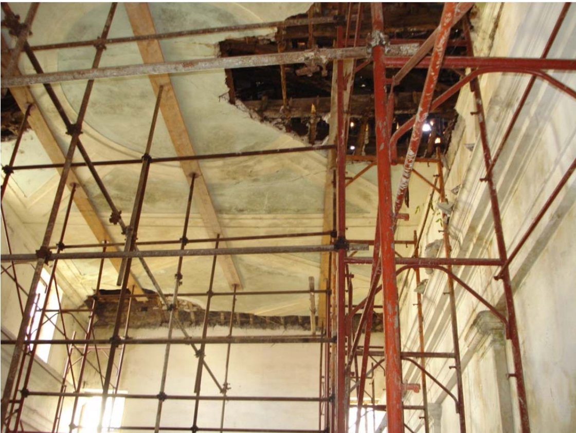
Particolare della controsoffittatura dell'oratorio
