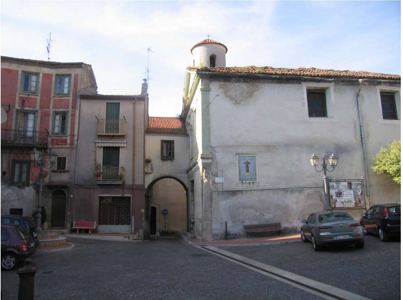
Arcovolto e campanile consolidati nel I Lotto (1989-1992)
