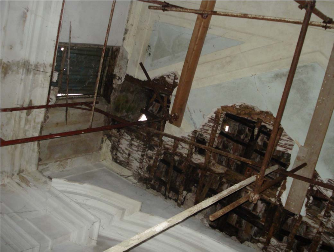
Particolare della controsoffittatura dell'oratorio
